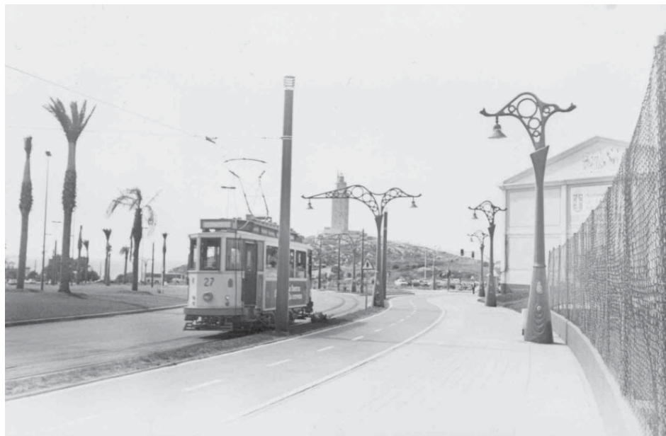
Ilustración 3-. Paseo Marítimo de Orillamar
