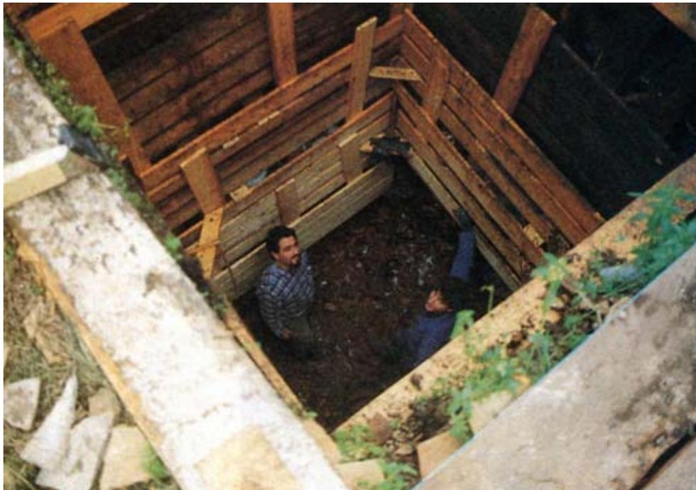
En la excavación se alcanzan los 5 m. de profundidad.
