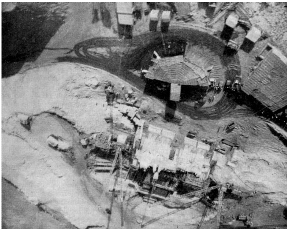
Vista área del proceso de reconstrucción del templo de Abu-Simbel, en su nuevo emplazamiento, a 68 metros más elevado que el anterior.
