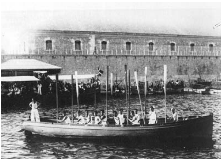
Imagen histórica. Obsérvese la inexistencia de revestimiento en los paramentos de fachada.
