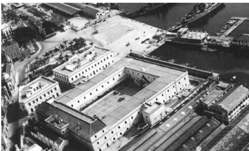
En esta imagen tomada en 1960 se aprecian los dos añadidos en la fachada norte, el primero en altura y el otro construido delante del edificio principal.
