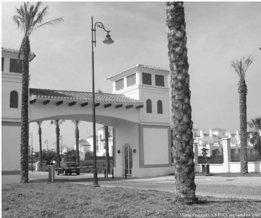
Figura 7. Encerramiento y seguridad (vista exterior del resort La Torre Golf)
