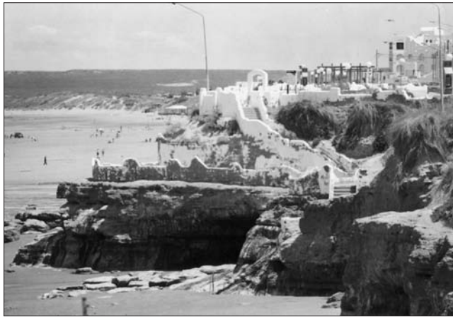
FIGURA 6: Edificaciones construidas sobre la costa acantilada de Las Grutas.
